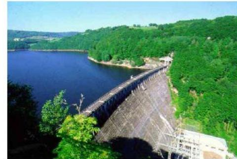
Un barrage poids en béton, de section droite triangulaire, repose sur le sol et réalise une retenue d'eau de hauteur  $h$  pour l'alimentation des voies navigables. Un barrage poids est un barrage dont la propre masse suffit à résister à la pression exercée par l'eau.
